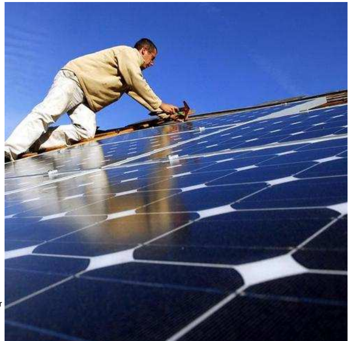
Les panneaux dits intégrés produisent de l'électricité et assurent l'étanchéité.
