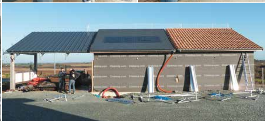
La plateforme pédagogique solaire thermique et photovoltaïque.
