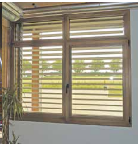
Store à lames orientables, vue de l'intérieur.
