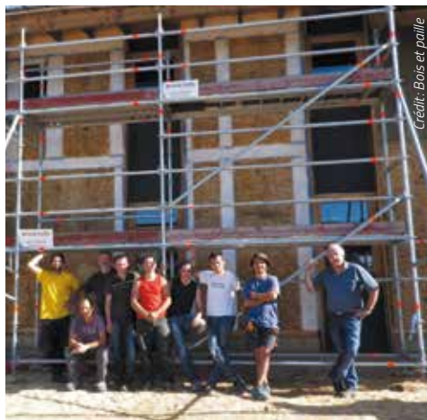
Le chantier école pour le mur en paille.
