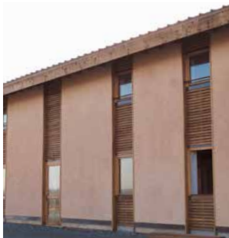
Le mur Nord isolé en bottes de pailles, sauf au niveau des allèges.
