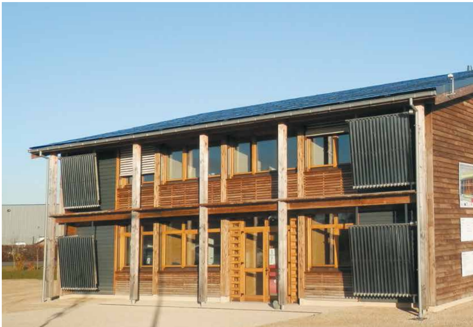
Une façade Sud largement vitrée, mais pas trop : gare aux surchauffes, même en hiver...
