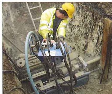
Mini foreuse PIT fond de fouille
