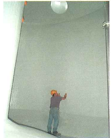
Revêtement époxydique armé (Limerzel - 56)
