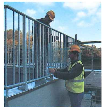
Mise en sécurité (Saint-Thurial - 35)
