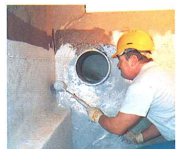
Revêtement anti-corrosion (Port-de-Roche - 35)
