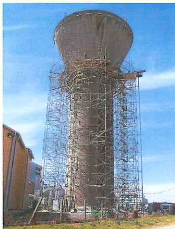
Réservoir de Mayenne (53)
