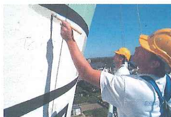
Décoration et revêtement extérieur (Vern-sur-Seiche - 35)
