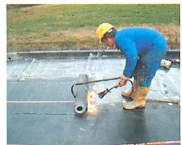
Etanchéité bitume-élastomère (Montfort - 35)
