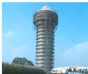
Réparation des structures et ravalement (Saint-Divy - 29)
