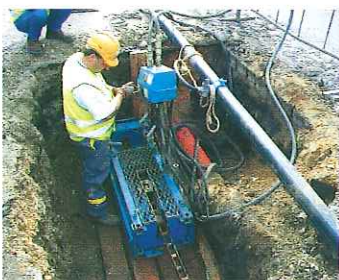
Éclatement à partir d'un puits de travail
